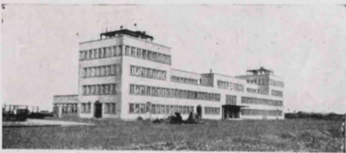
Bâtiment administratif de l'Aéroport de Munich. Architecte : J. Mossner. ("Ostdeutsche Bauzeitung", Breslau, N° 29.)
